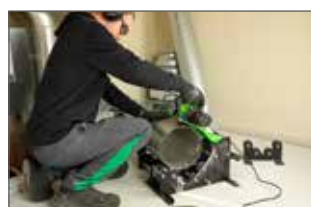
Schnelles Schneiden von Lüftungsrohren
