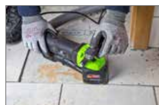
Schleifen von Fliesenkleber
