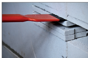
Gebruik van de afstandhouders (optioneel), plaats 3 of 4 schijven tegelijk
